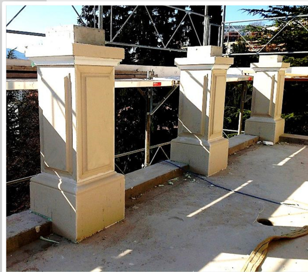
Copertura di pilastri in cemento con polistirolo rivestito. ( Lavoro in esecuzione )
