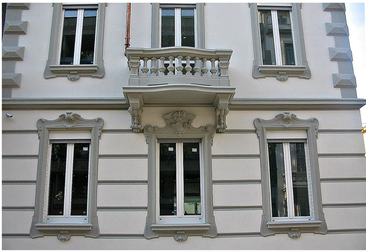
Facciata decorata in cemento
