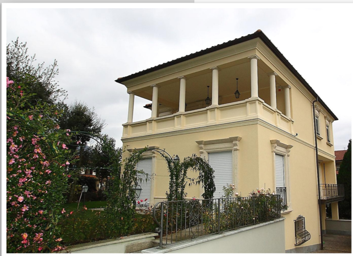
Parapetto in cemento
